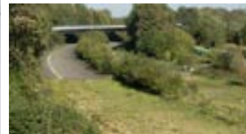
Rückbau AK Holz
